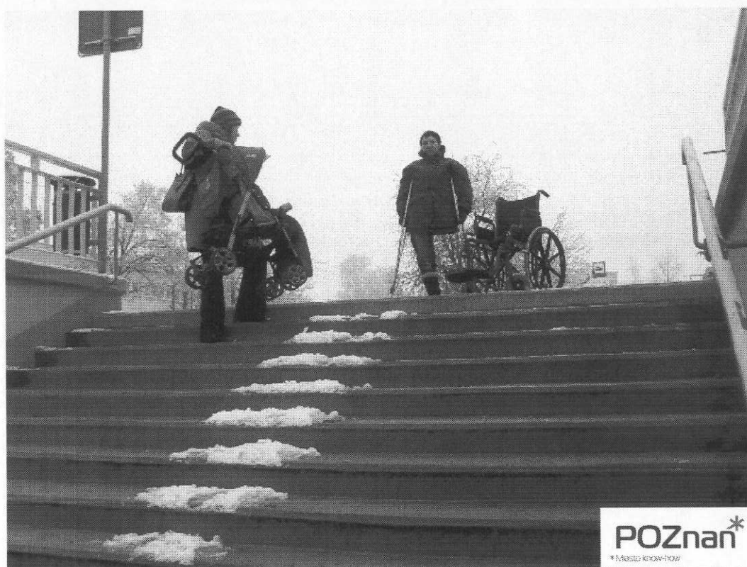
Fot.2. Dojście do platformy północnej jest całkowicie niedostępne dla osób niepełnosprawnych ruchowo;
