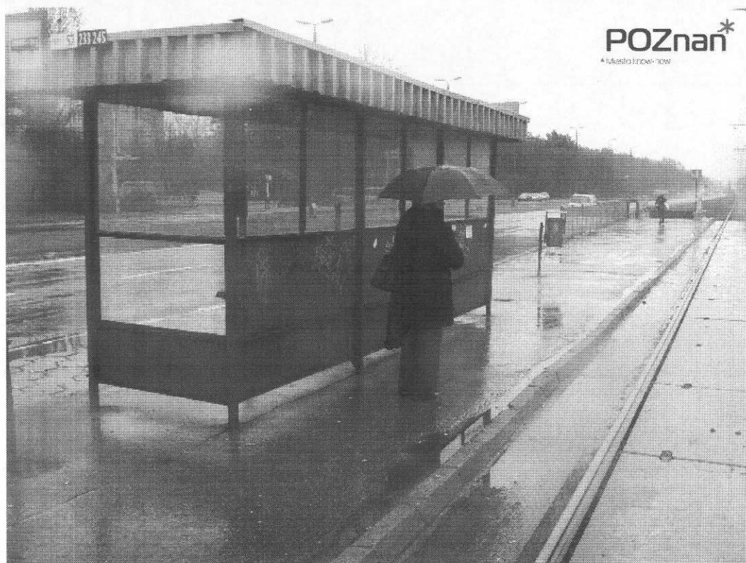
Fot. Źle zlokalizowana wiata przystankowa blokuje dojście osobom poruszającym się na wózku inwalidzkim
