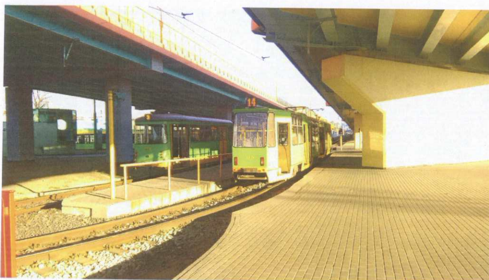
Fot. 2. Widok na torowisko od strony przejścia podziemnego.
