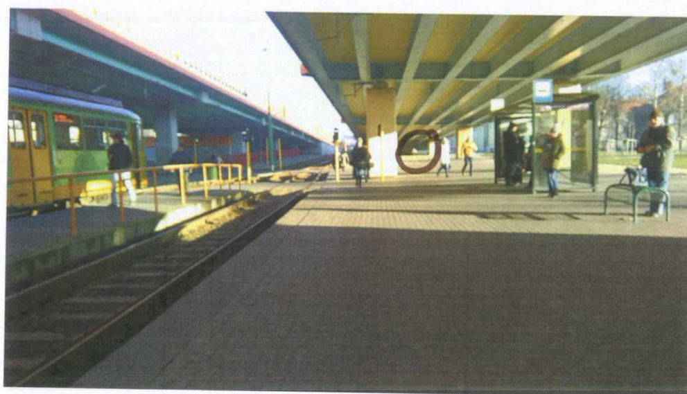
Fot. 3. Widok na przystanek tramwajowy od strony przejścia podziemnego. W kółku proponowana lokalizacja tablicy.
