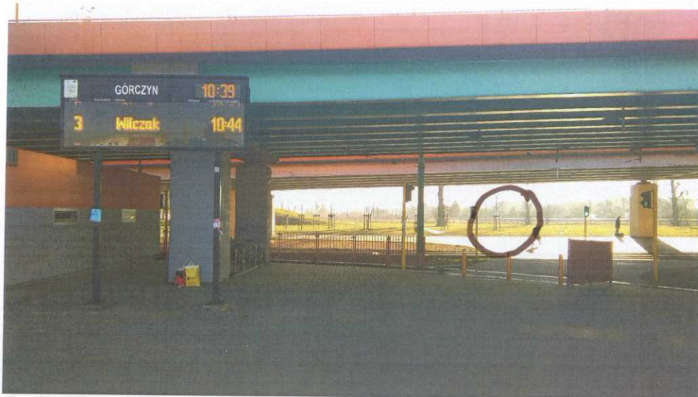
Fot. 1. Widok na przejście na przystanek tramwajowy od strony pętli autobusowej. W kółku proponowana lokalizacja tablicy.
