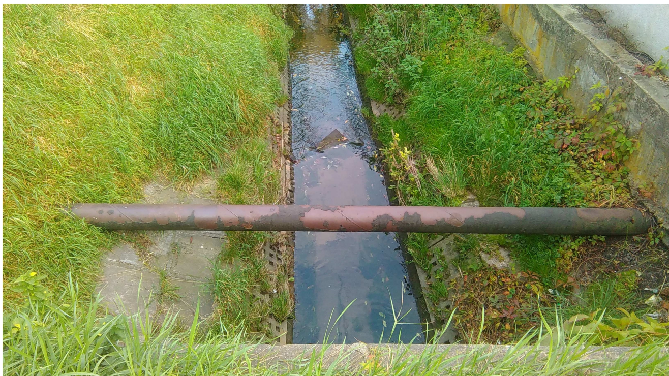
Ciek Górczynka – widoczna rura gazowa.
