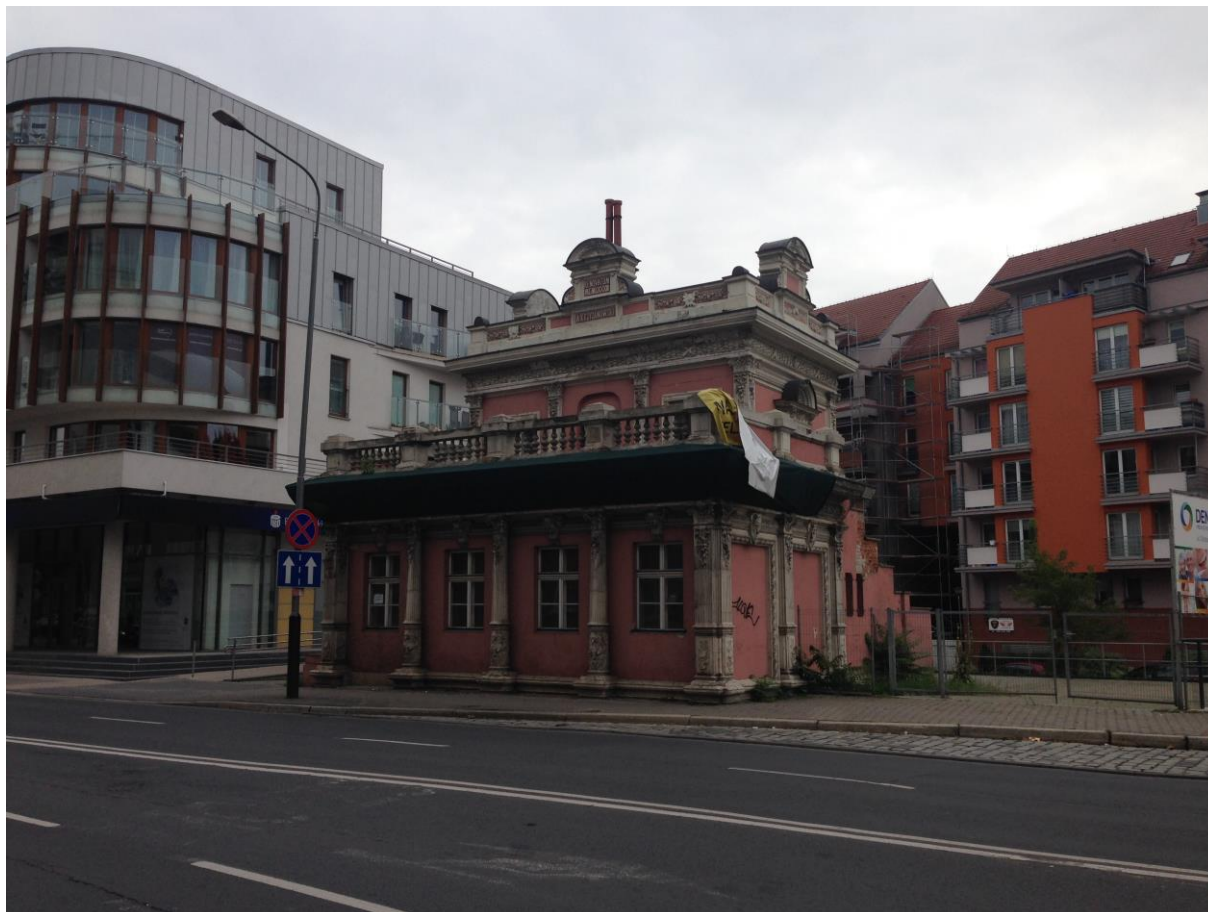
Zdjęcie - stan budynku we wrześniu 2017 roku
