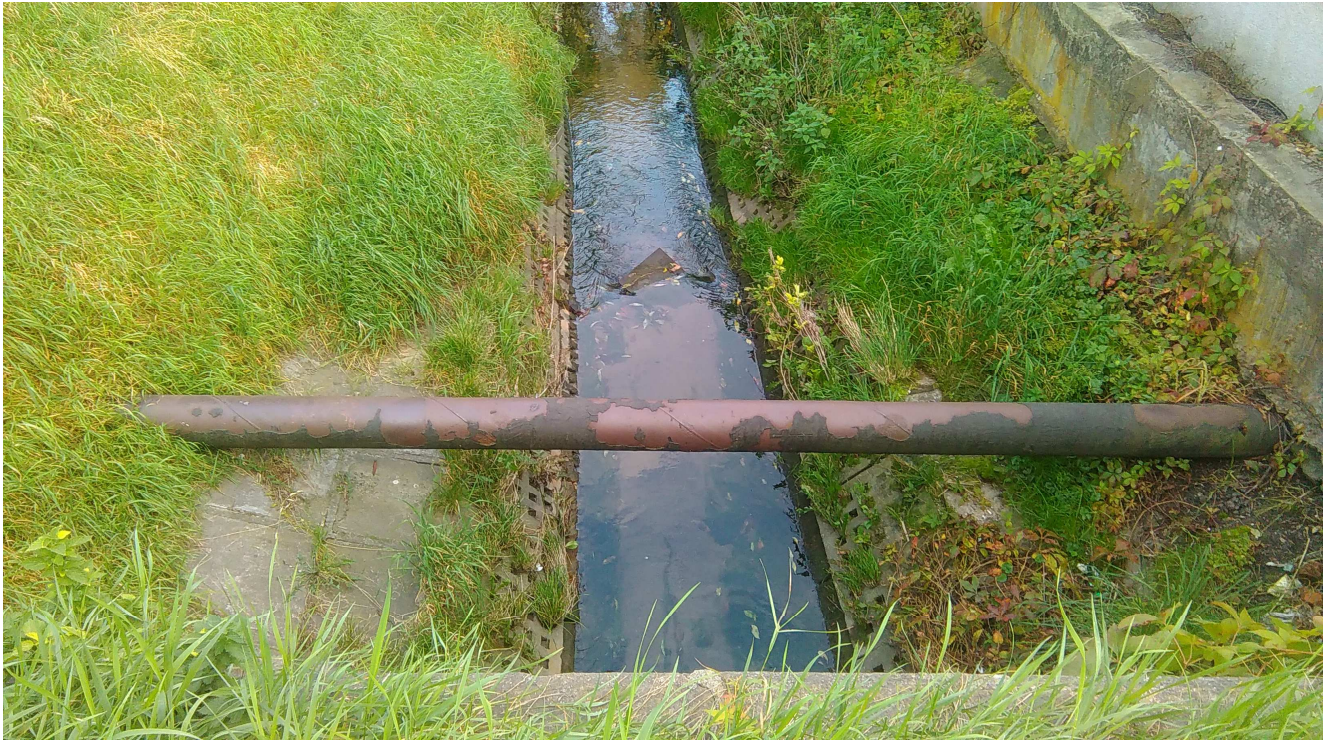
Ciek Górczynka – widoczna rura gazowa.
