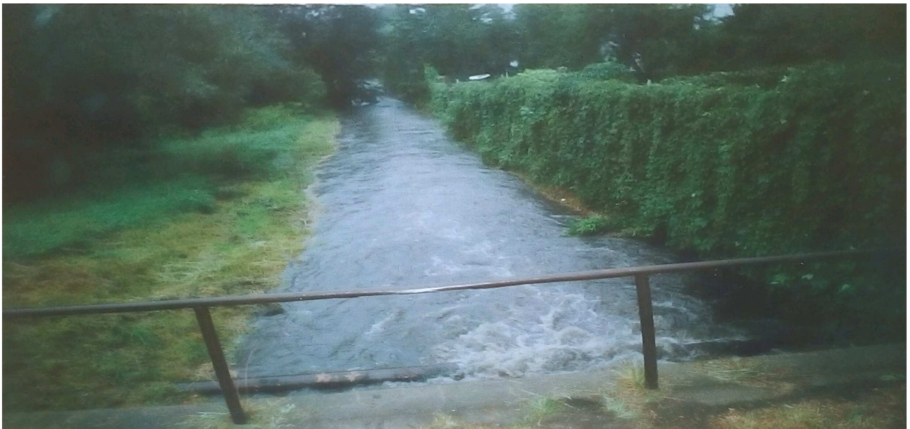
Ciek Górczynka w czasie opadów – rura gazowa w wodzie.
