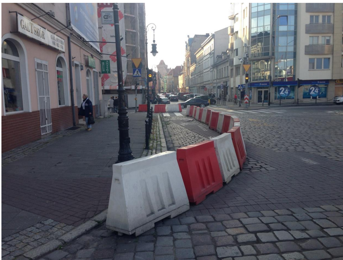
Zdjęcie - tymczasowa organizacja ruchu na ulicy Wielkiej (na odcinku między ulicą Garbary a ulicą Mostową)
