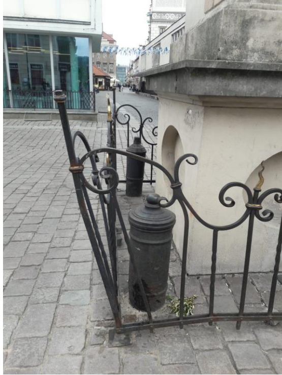
Zdjęcie - uszkodzone ogrodzenie figury Świętego Jana Nepomucena na Starym Rynku
