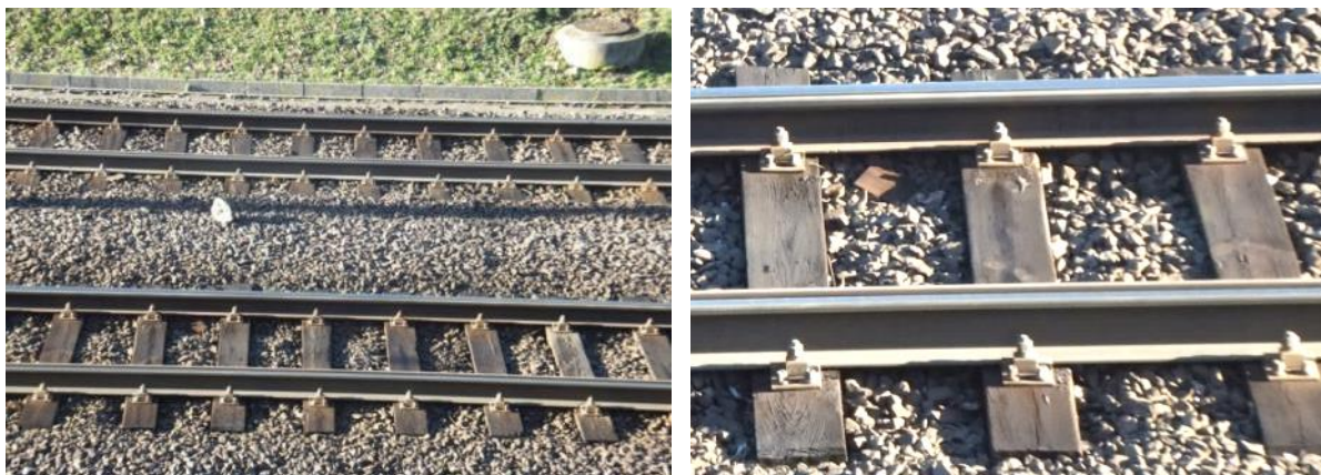
Rys. 37 Torowisko tramwajowe linii PST o sztywnym mocowaniu szyn bezстыkowych, podkładach drewnianych i podsypce (tłuczeń); przy ul. Kurpińskiego w Poznaniu
