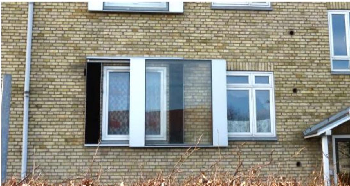
Rys. 59 Dodatkowa, ruchoma elewacja szklana zamontowana przed oknem pomieszczenia mieszkalnego, pozostawiając możliwość otwarcia okna (źródło: CEDR Call 2012: Noise; ON-AIR Optimised Noise Assessment and Management Guidance for National Roads; Investigation of noise planning procedures and tools, 2015)
