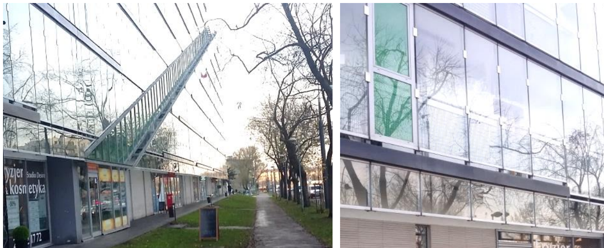
Rys. 61 Dodatkowe elewacje szklane osłaniające balkony na całej frontowej powierzchni budynku mieszkaniowo-usługowego przy ul. Banderii w Warszawie.
