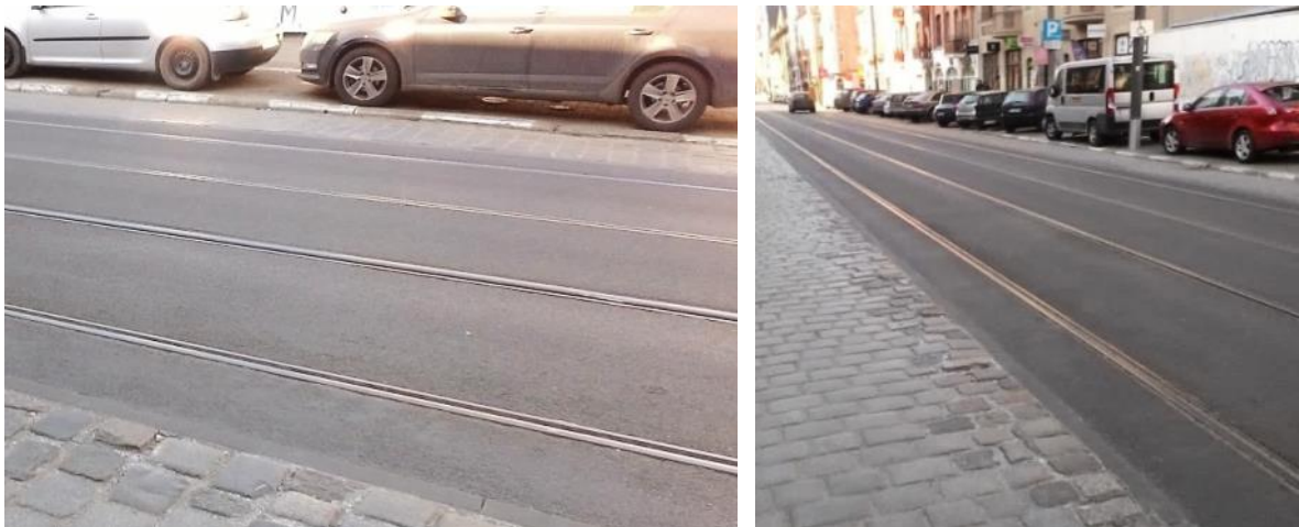
Rys. 36 Przykład zmodernizowanej ul. Dąbrowskiego w Poznaniu – częściowa wymiana nawierzchni w jezdni z kostki na asfalt wzdłuż torowiska tramwajowego umożliwia cichszy przejazd samochodem
