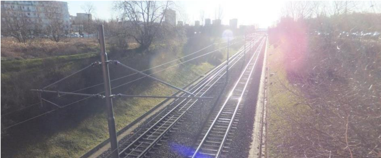
Rys. 54 Wały ziemne wzdłuż linii tramwajowej PST w Poznaniu; torowisko zlokalizowane jest poniżej poziomu terenu na którym znajduje się zabudowa mieszkaniowa
