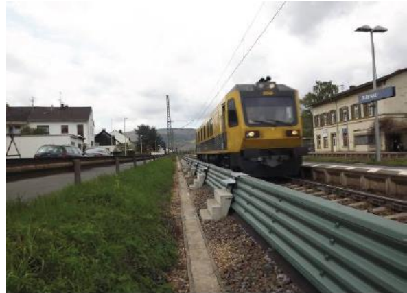
Rys. 50. Niski ekran przeciwhałasowy (wysokość 0,75 m) (DB Netze: Innovative Maßnahmen zum Lärm- und Erschütterungsschutz am Fahrweg, Schlussbericht, 2012)
