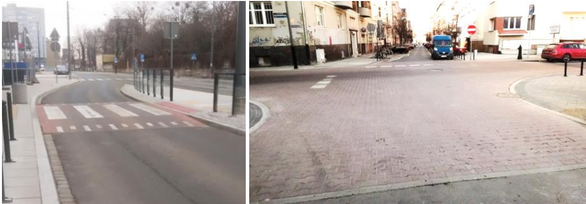
Rys. 29. Wyniesione przejście dla pieszych na ul. Zwierzynieckiej oraz wyniesione skrzyżowanie ulicy Sienkiewicza z ulicą Prusa w Poznaniu
