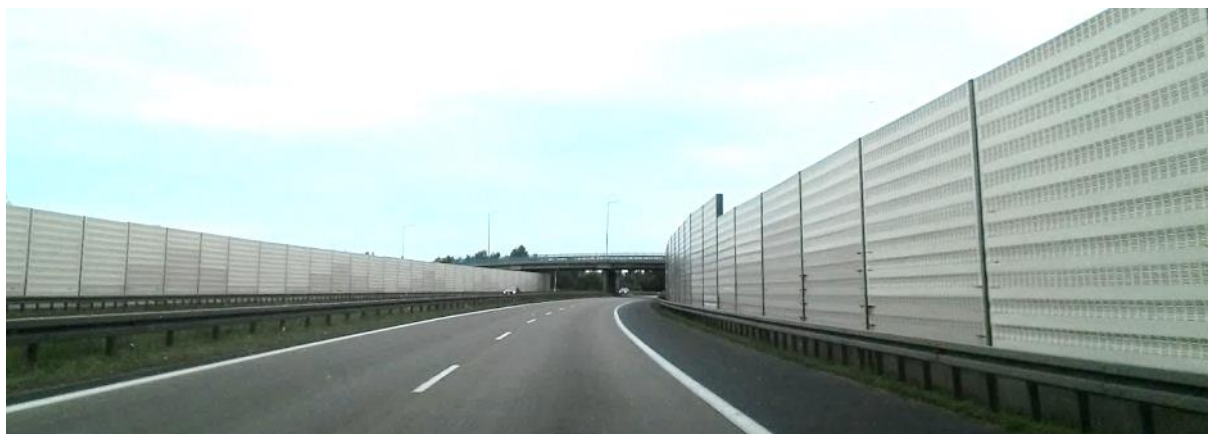
Rys. 49 Ekrany przeciwhałasowe pochłaniające (zbudowane z kasetonów) wzdłuż DK 11 w Poznaniu
