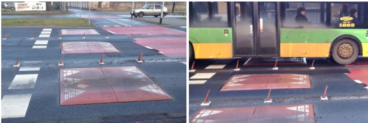
Rys. 30. Poduszki berlińskie - specjalny próg spowalniający ruch pojazdów osobowych. Poduszki berlińskie są wąskimi wyniesieniami, umożliwiającymi niezakłócony przejazd pojazdom ciężkim np. autobusom komunikacji miejskiej (rozstaw kół jest szerszy niż wymiar poduszki)
