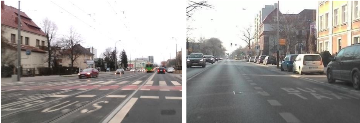
Rys. 26 Modernizacja ul. Dąbrowskiego w Poznaniu - drogi rowerowe, buspasy, wydzielone torowisko w jezdni, redukcja pasów ruchu dla pojazdów osobowych do jednego na kierunek (zdjęcie po lewej); buspas w ciągu ul. Bukowskiej w Poznaniu (zdjęcie po prawej)
