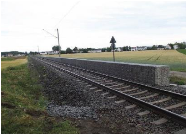
Rys. 50. Niski ekran przeciwhałasowy (wysokość 0,75 m) (DB Netze: Innovative Maßnahmen zum Lärm- und Erschütterungsschutz am Fahrweg, Schlussbericht, 2012)
