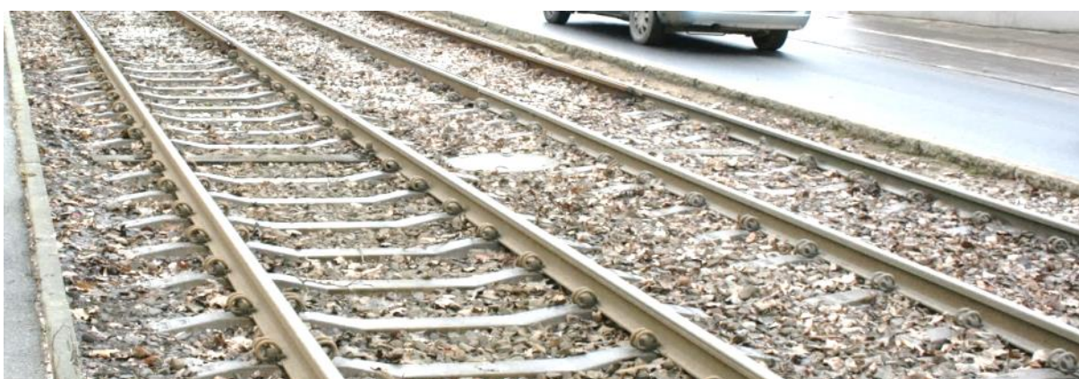
Rys. 38 Przykład wydzielonego torowiska o podkładach strunobetonowych, mocowaniu sprężystym i szynach bezстыkowych na podsypce (tłuczeń); Al. Wielkopolska w Poznaniu
