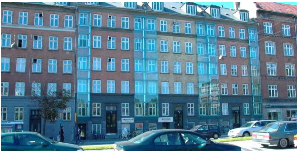
Rys. 60 Elewacje szklane przy fasadach pomieszczeń sypialnianych budynku ulokowanego tuż przy drodze głównej; brak miejsca na budowę ekranu akustycznego (źródło: jw).
