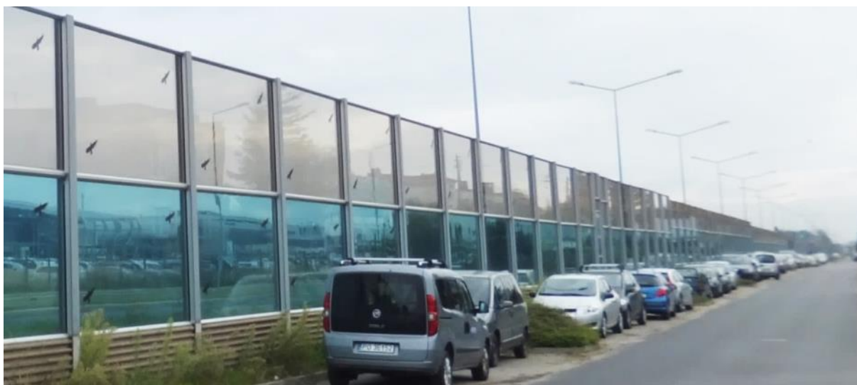
Rys. 45. Ekran przeciwhałasowy odbijający (zbudowany z szkła akrylowego i keramzytobetonu u podstawy) przy ul. Bukowskiej w Poznaniu
