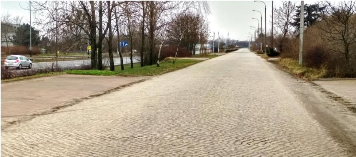
Rys. 35 Przykład drogi o nawierzchni z kostki brukowej na terenie Poznania. Emisja hałasu pojazdu poruszającego się po tego rodzaju nawierzchni jest większa o ok. 3 dB względem ruchu - na asfaltobetonie przy zachowaniu tej samej prędkości (dane na podstawie NMPB-Routes-08)
