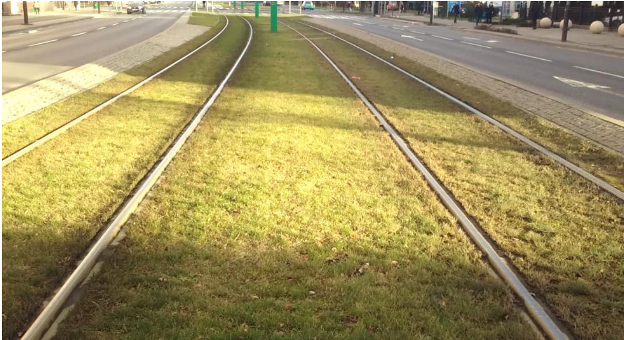
Rys. 39 Zielone torowisko przy ul. Grunwaldzkiej - strunobetonowe torowisko bezстыkowe z matami wibroizolacyjnymi w obrębie platform i przejazdów oraz wkładkami w komorach łukowych
