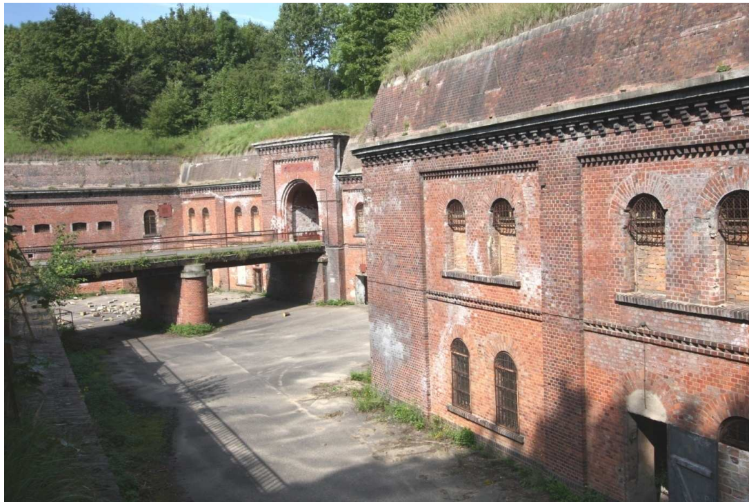
Foto. 1. Fort VI –wejście główne od strony ulicy Lutyckiej
