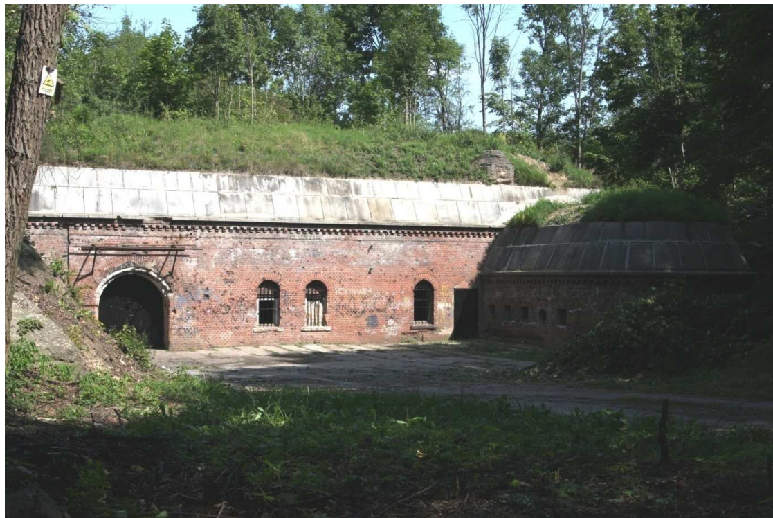
Foto. 3 i 4. Fort Va - wejście główne od strony ulicy Lechickiej
