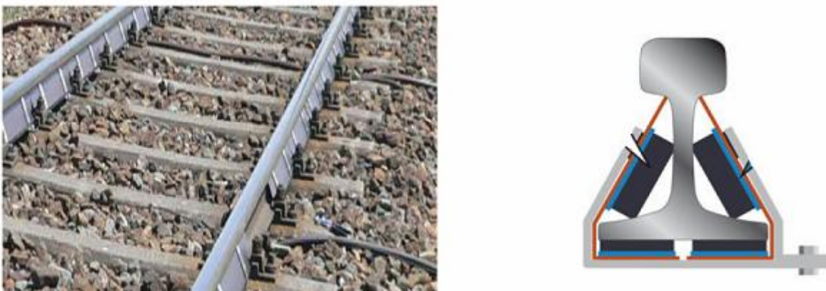
Rys. 34. Osłony szyn (DB Netze: Innovative Maßnahmen zum Lärm- und Erschütterungsschutz am Fahrweg, Schlussbericht, 15.06 2012)
