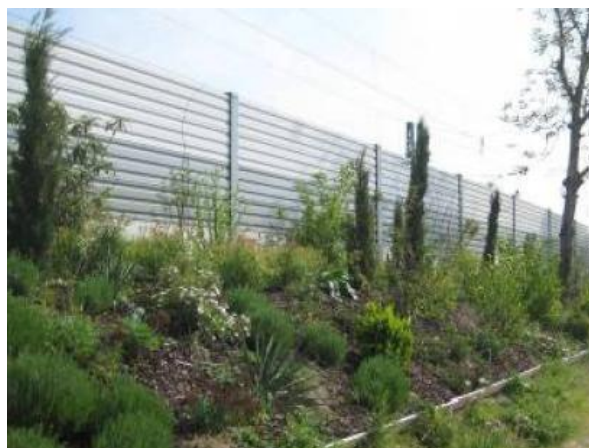
Rys. 38. Niski ekran przeciwhałasowy, odchylany - (DB Netze: Innovative Maßnahmen zum Lärm- und Erschütterungsschutz am Fahrweg, Schlussbericht, 15.06 2012)
