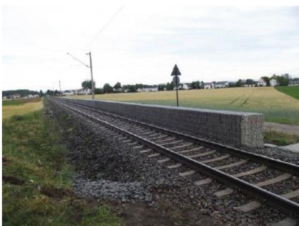
Rys. 36. Niski ekran przeciwhałasowy (wysokość 0.75 m) - (DB Netze: Innovative Maßnahmen zum Lärm- und Erschütterungsschutz am Fahrweg, Schlussbericht, 15.06 2012)
