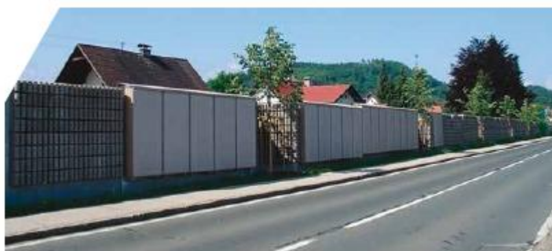
Rys. 27. Ekran przeciwhałasowy (pochłaniający) (Optimised noise barriers, A state of the art report, Danish Road Institute, Report 194 – 2011)
