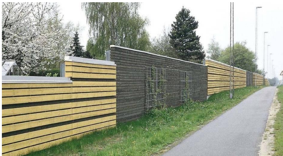
Rys. 28. Ekran przeciwhałasowy (drewniany) (zdjęcie własne)
