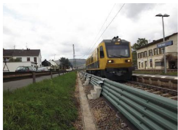
Rys. 36. Niski ekran przeciwhałasowy (wysokość 0.75 m) - (DB Netze: Innovative Maßnahmen zum Lärm- und Erschütterungsschutz am Fahrweg, Schlussbericht, 15.06 2012)
