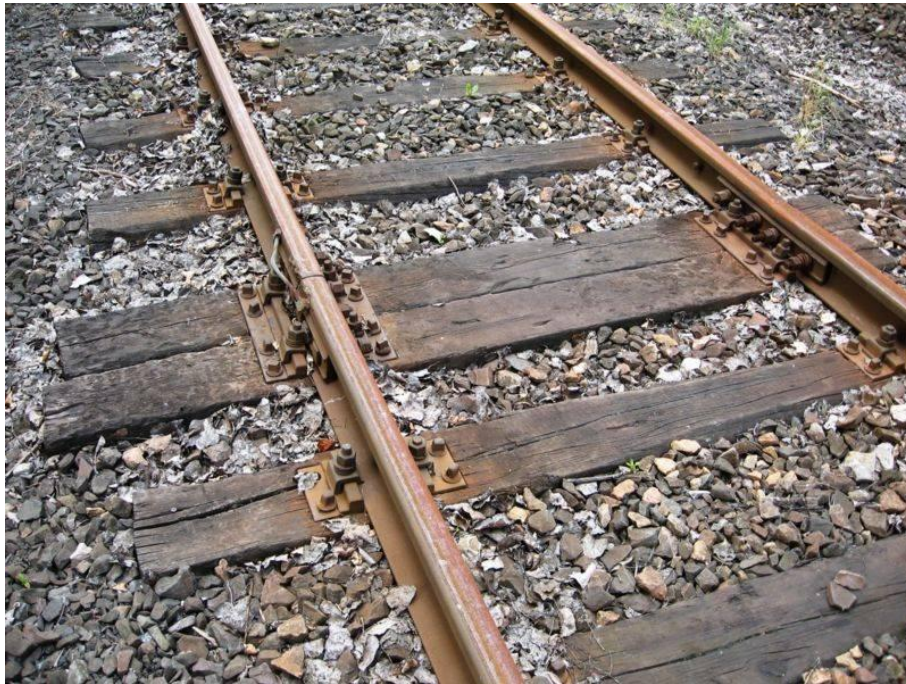
Rys. 31. Torowisko kolejowe. Szyny stykowe, mocowanie szyn do podkładów „na sztywno” (zdjęcie własne)
