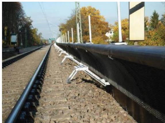
Rys. 37. Niski ekran przeciwhałasowy, nieodchylany - (DB Netze: Innovative Maßnahmen zum Lärm- und Erschütterungsschutz am Fahrweg, Schlussbericht, 15.06 2012)
