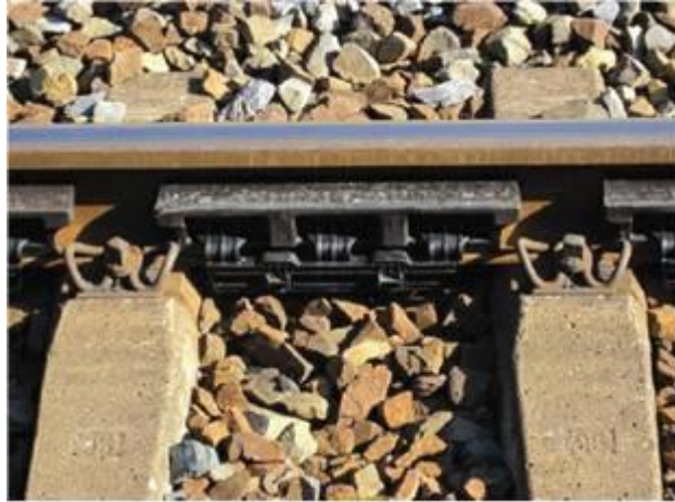
Rys. 35. Tłumiki drgań (DB Netze: Innovative Maßnahmen zum Lärm- und Erschütterungsschutz am Fahrweg, Schlussbericht, 15.06 2012)
