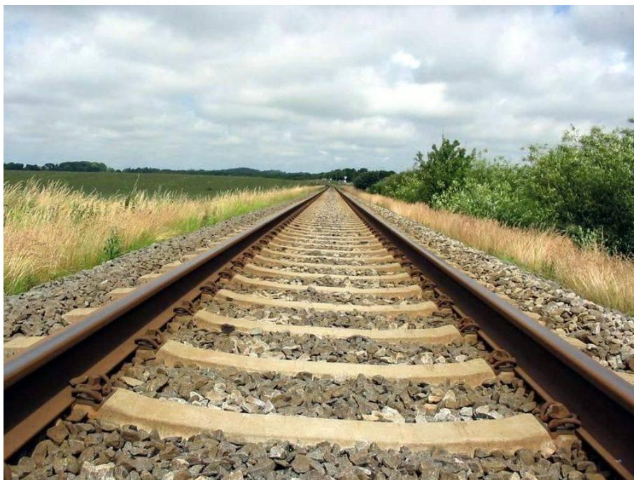
Rys. 32. Torowisko kolejowe. Szyny bezstykowe, mocowanie szyn do podkładów kolejowych z wykorzystaniem sprężystych podkładek (zdjęcie własne)
