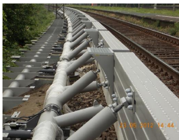
Rys. 38. Niski ekran przeciwhałasowy, odchylany - (DB Netze: Innovative Maßnahmen zum Lärm- und Erschütterungsschutz am Fahrweg, Schlussbericht, 15.06 2012)
