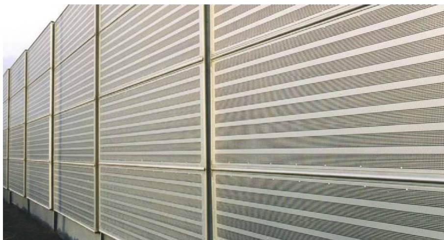
Rys. 30. Ekran przeciwhałasowy (dźwiękochłonny) (zdjęcie własne)
