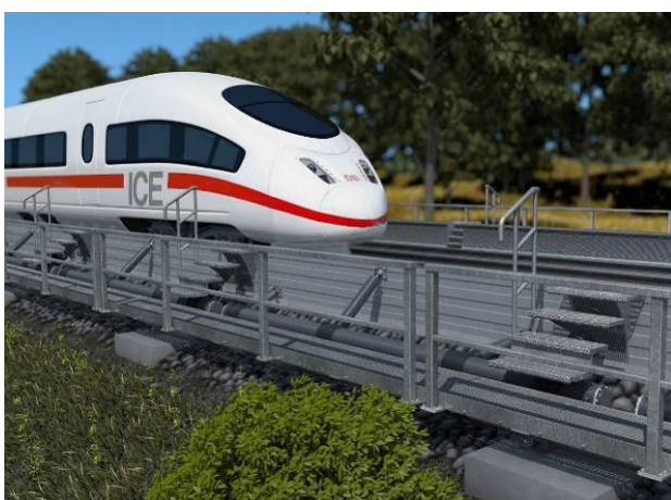
Rys. 38. Niski ekran przeciwhałasowy, odchylany - (DB Netze: Innovative Maßnahmen zum Lärm- und Erschütterungsschutz am Fahrweg, Schlussbericht, 15.06 2012)
