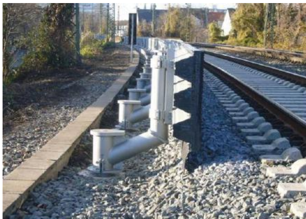
Rys. 37. Niski ekran przeciwhałasowy, nieodchylany - (DB Netze: Innovative Maßnahmen zum Lärm- und Erschütterungsschutz am Fahrweg, Schlussbericht, 15.06 2012)
