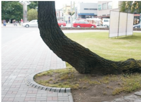
Ryc. 9.2. Wyznaczenie krawężnikiem miejsca ominięcia przeszkód w obrębie ciągu pieszego. (zdj. autora)
