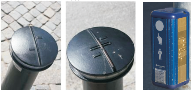
Ryc. 5.7. Schematy dotykowe przejścia dla pieszych mogą ułatwić wytyczenie kierunku przechodzenia przez jezdnię. Schematy przejść: a) bez wysepki, b,c) z wydzieloną wysepką. (zdj. M. Wysocki)
