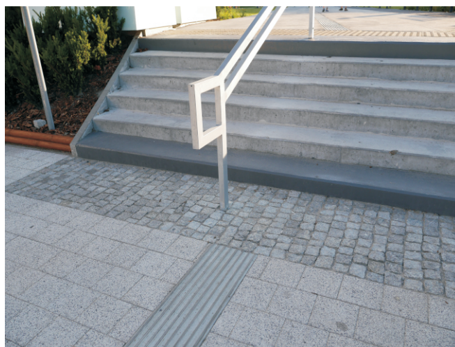
Ryc. 7.7. Pierwszy i ostatni stopień w biegu schodowym może być wykonany w całości jako kontrastowy z innymi stopniami i spocznikiem (autor: M. Wysocki)
