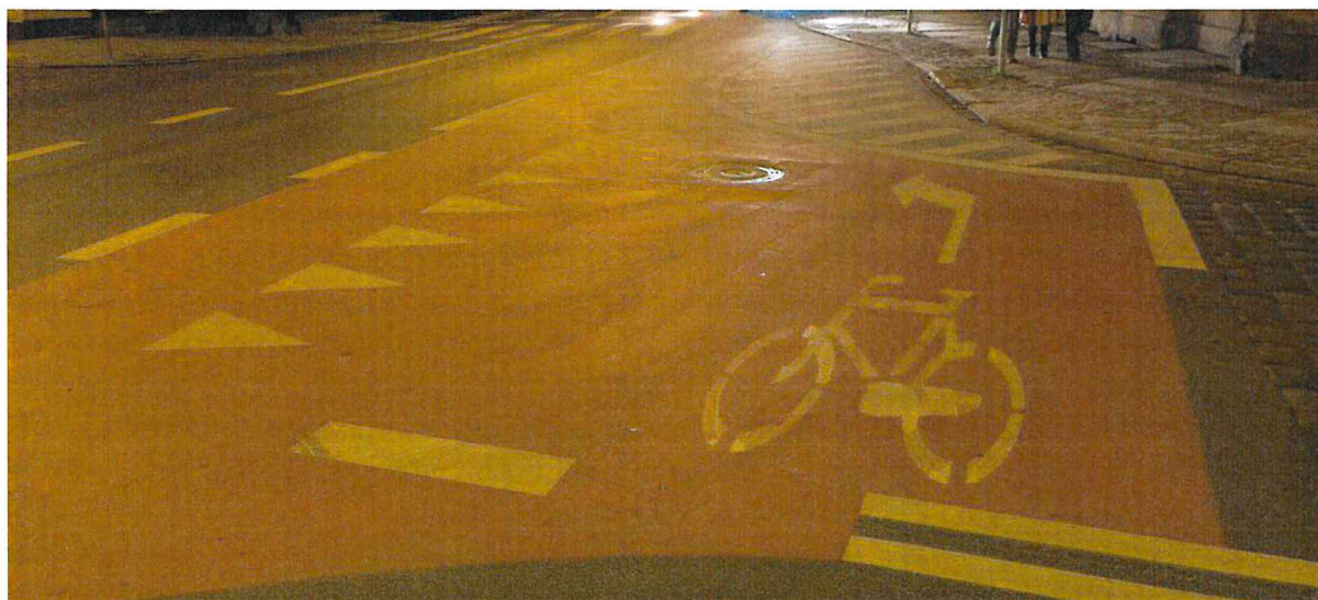
Fot. 9. Śluza typu 2, Poznań, skrzyżowanie ul. Mostowej i ul. Grobla. Oznakowanie zgodne z przepisami określonymi w D.U.2015.1314. Niniejszy dokument na wlocie śluzy proponuje linię P-3b (rys. 20B i rys. 20C).
