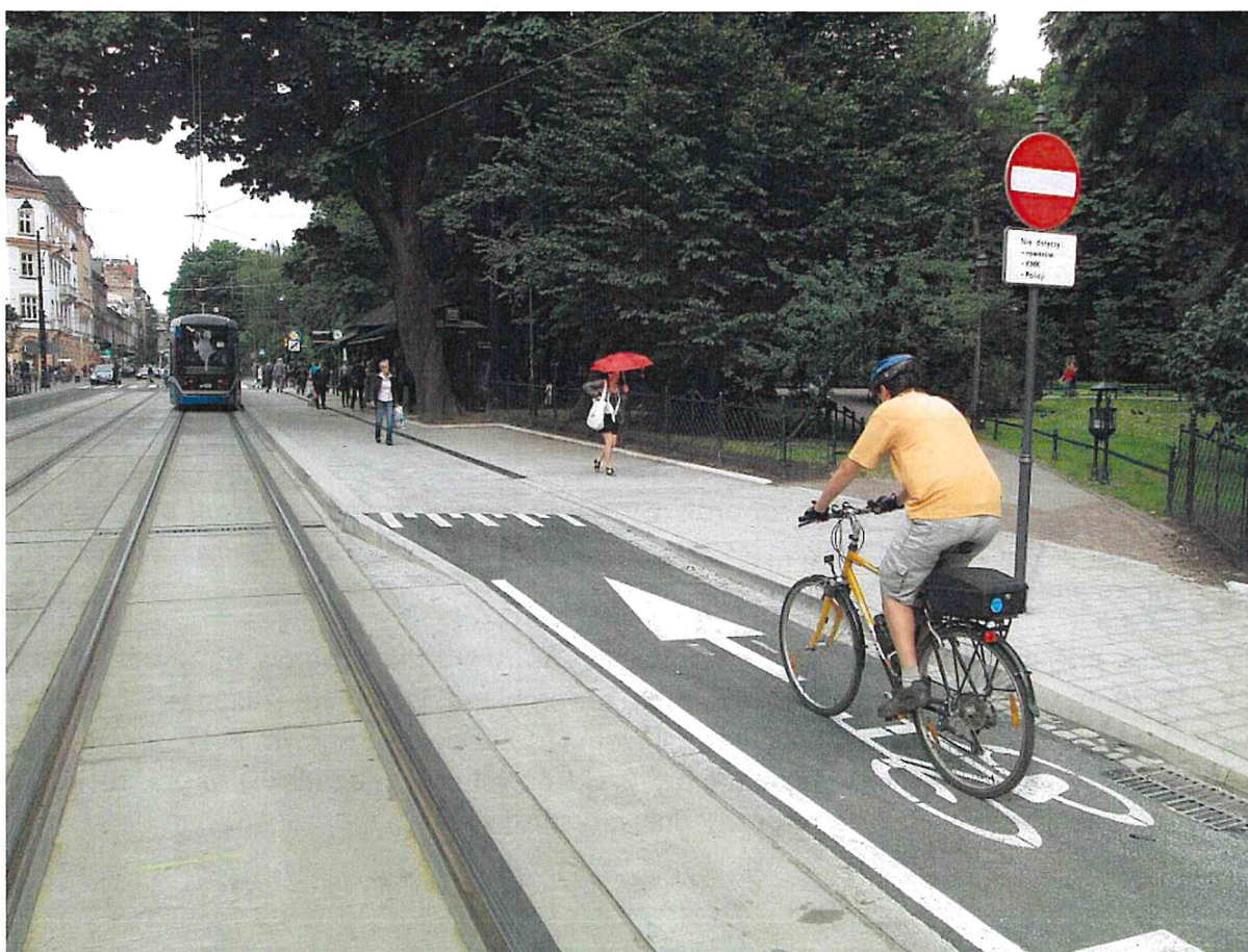
Fot. 4. „Przystanek wiedeński” zlokalizowany w przedłużeniu pasa ruchu dla rowerów (kontrapasa). Ze względu na wspólny ruch tramwajów i autobusów zastosowano krawężnik typu „kassel” umożliwiający bezpieczny dojazd autobusu do krawędzi. Kraków, ul. Podwale.
