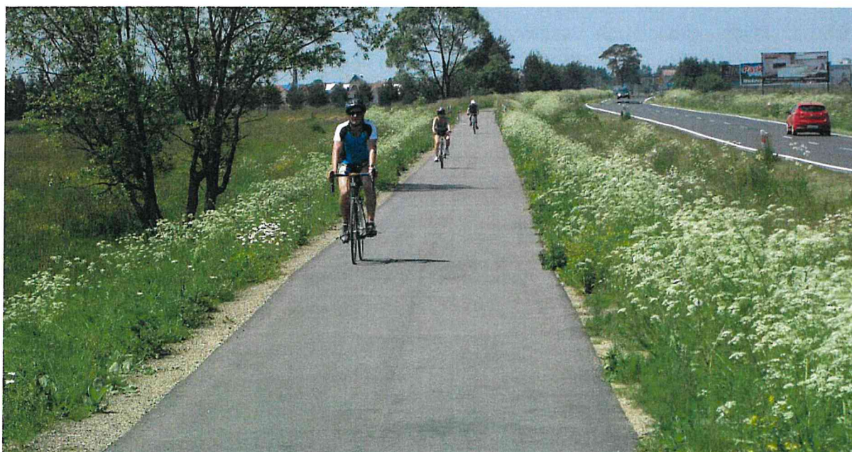
Fot. 6. Droga dla rowerów o nawierzchni asfaltowej wykonana na poszerzonej podbudowie, bez zbędnych i podnoszących koszty obrzeży lub krawężników. Droga wojewódzka nr 957, fragment trasy rowerowej euroregionu Tatry Nowy Targ – Sucha Hora/Trstena (Słowacja).
