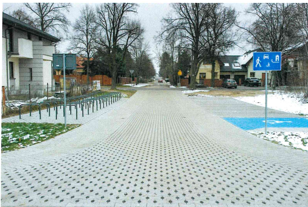
Pasy pełnej nawierzchni na ulicy o ażurowej nawierzchni na osiedlu Podolany w Poznaniu
