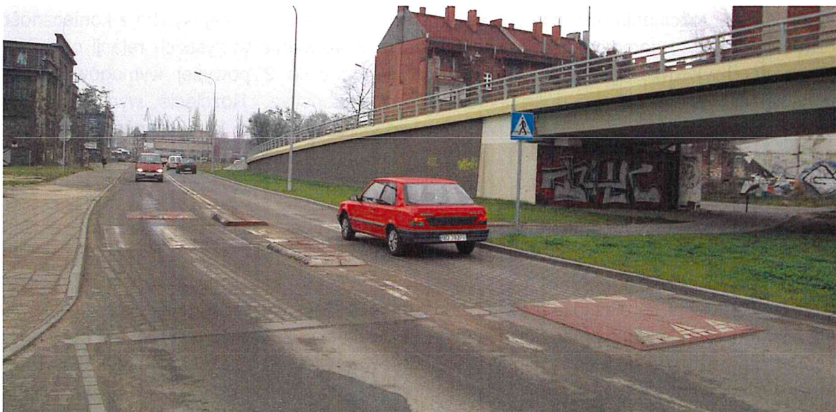
Fot. 2. Przykład uspokojenia ruchu przy pomocy prawidłowo umieszczonych progów wyspowych uzupełnionych wyspą dzielącą. Niemożliwe jest ominięcie progów. Gdańsk, ul. Narzędziowców.
