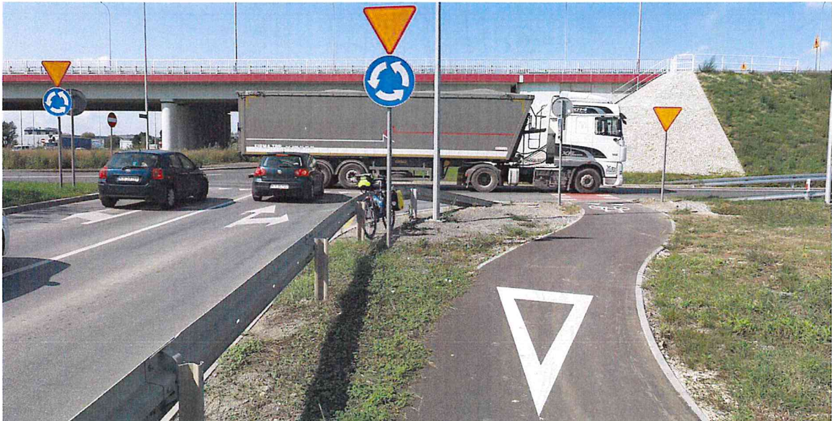
Fot. 11. Poprawne oznakowanie przejazdu dla rowerzystów przez wylot ronda turbinowego. Pojazdy opuszczające dwoma pasami ruchu rondo nie skręcają w drogę poprzeczną i zachodzi konieczność ustalenia pierwszeństwa na przejeździe znakami drogowymi. Węzeł „Rybitwy”, droga ekspresowa S-7, Kraków.
