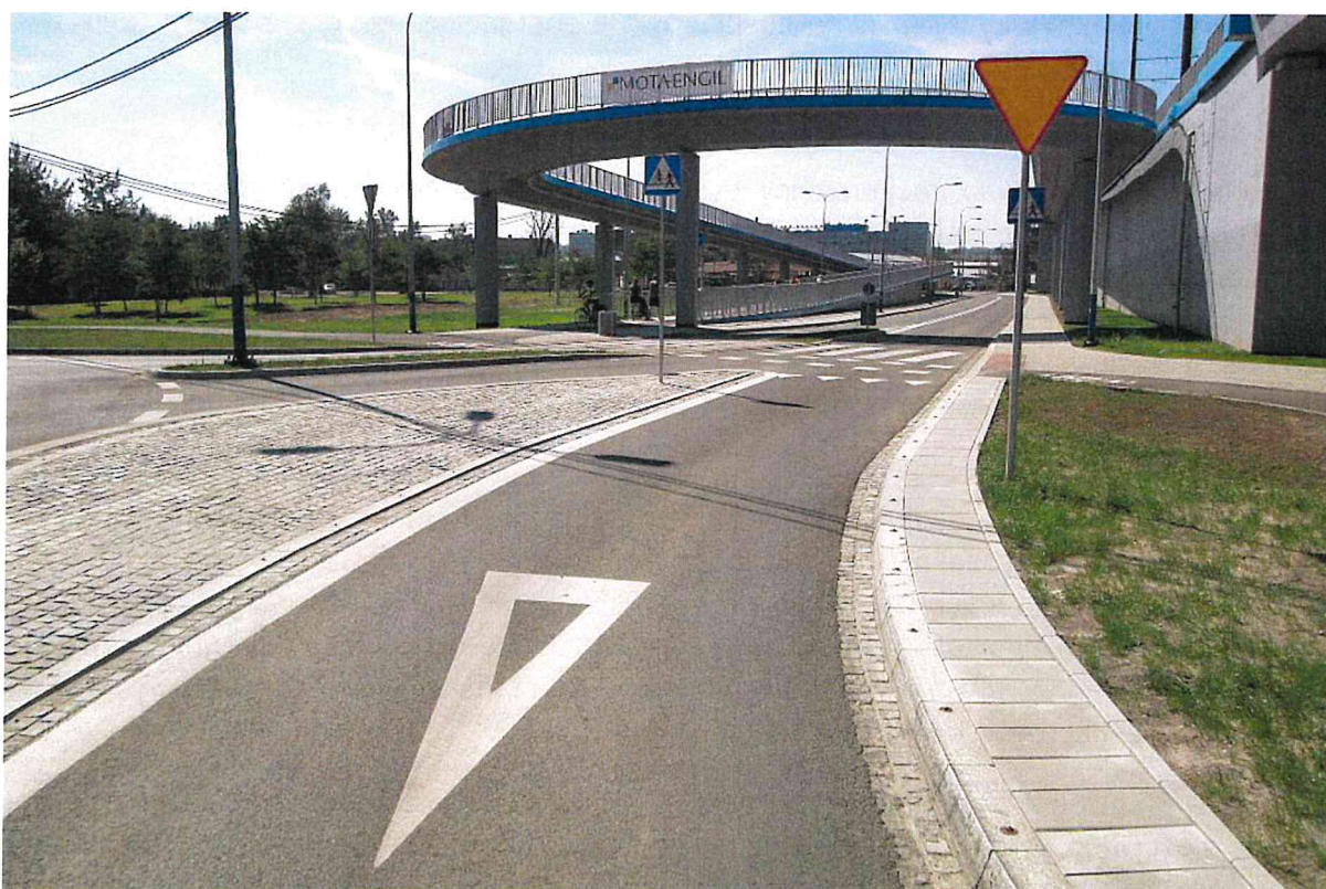
Fot. 14. Poprawne oznakowanie przejazdu dla rowerzystów przecinającego łącznicę („bypass”). Za znakiem poziomym P-15 i pionowym A-7 widać znak D-6b który nie ustala pierwszeństwa i jest jedynie znakiem informacyjnym. Przed przejazdem dla rowerzystów wyznaczono linię zatrzymań złożoną z trójkątów (P-13). Kraków, ul. Saska.
