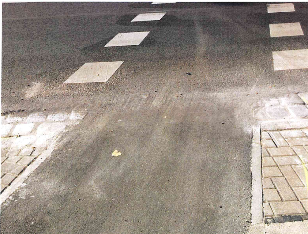
Przykłady łączenia bezkrawężnikowego drogi dla rowerów z przejazdem rowerowym przez ulice wyższej klasy na poziomie jezdni – Wrocław.
